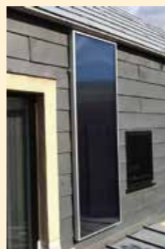
ソーラーウォーマー設置
