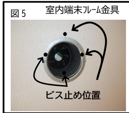
図5 室内端末フレーム金具
